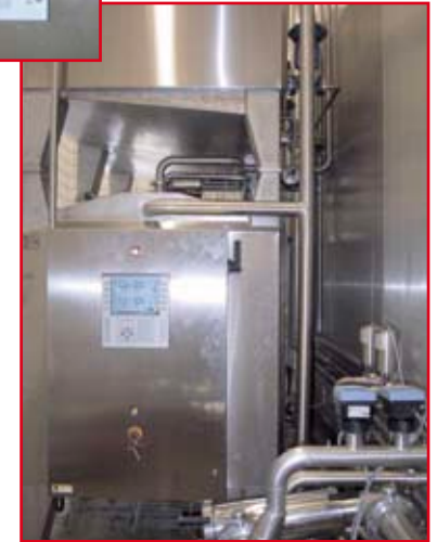
Chauffage vapeur par échangeur tubulaire
